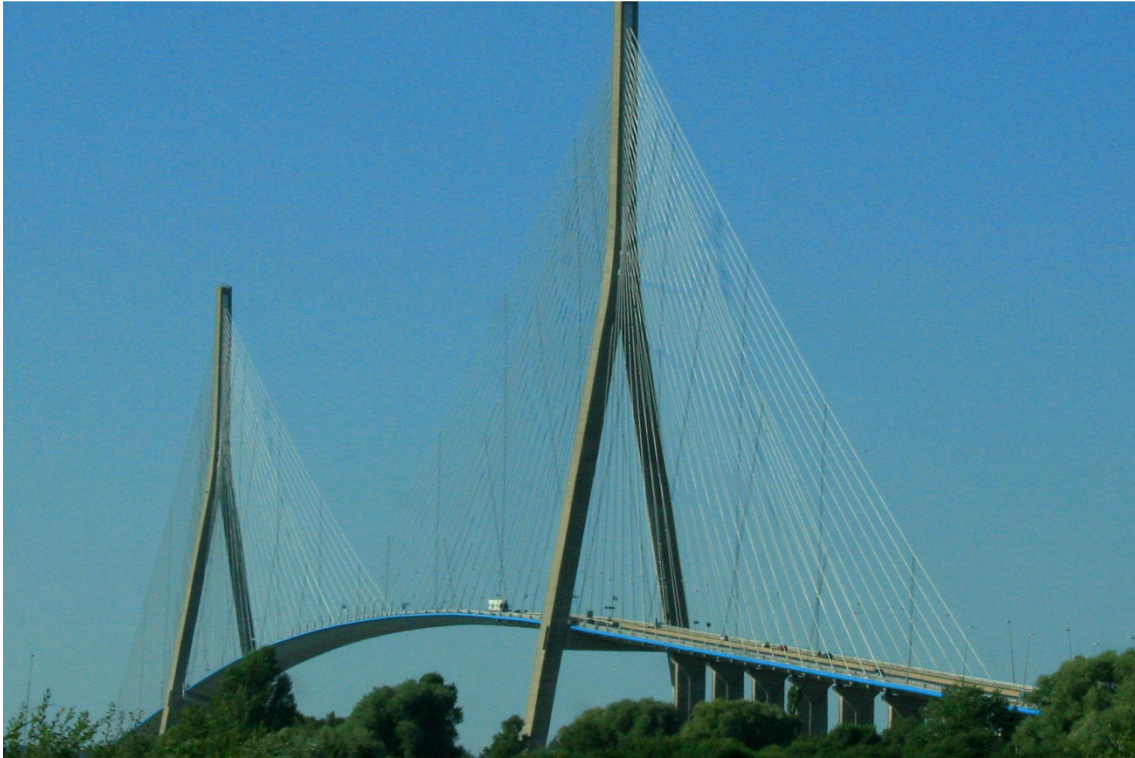
Foto 32: Schrägseilbrücke Pont de Normandie,
