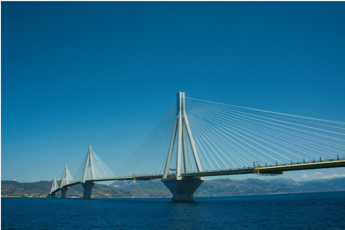
Foto 30: Schrägseilbrücke Rio-Antirio Brücke
